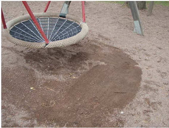
Fel sand, vilket har medfört att sanden packats hårt och den stötdämpande förmågan har minskat.
