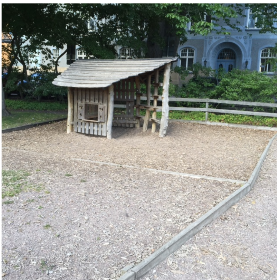
Sand, grus och en kant gör det svårt att ta sig fram till huset om man använder rullstol.
