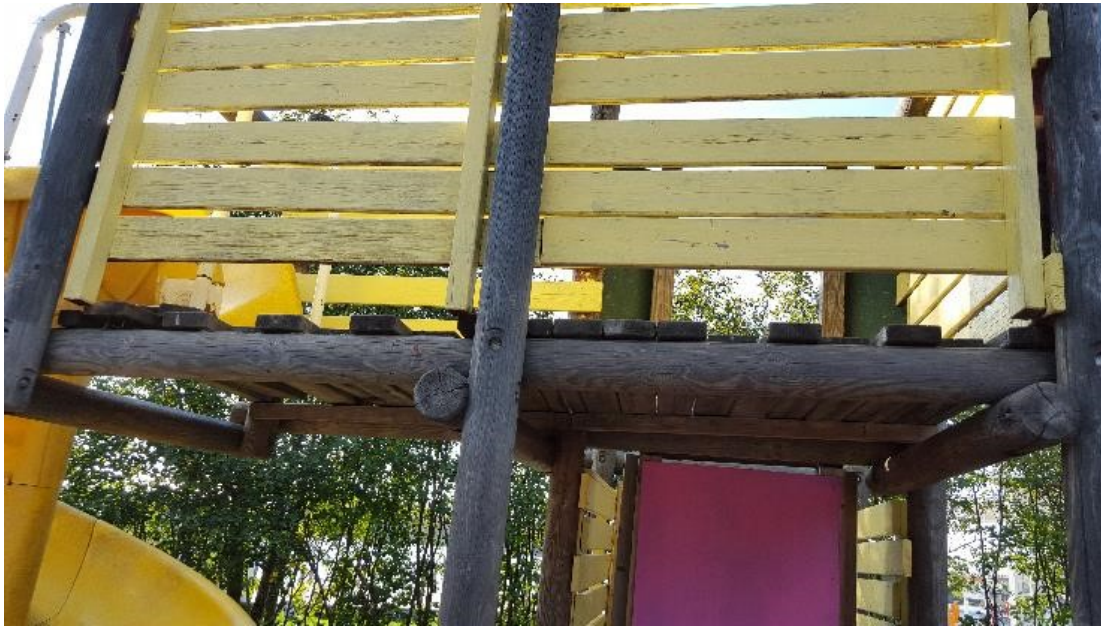
En klätterställning med öppningar vid golvet där barnet kan komma igenom med kroppen och bli hängande i huvudet.
