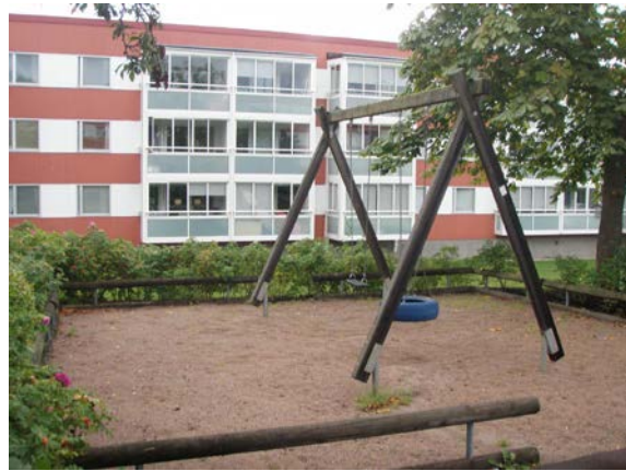
Staketet är placerat inom fallutrymmet från gungan.
