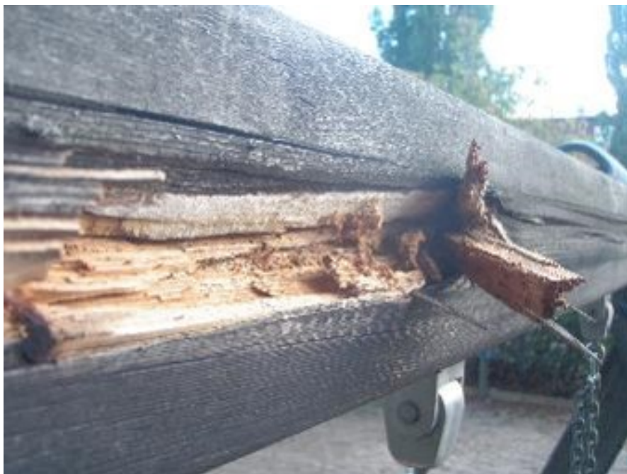
En gungställning där bommen ruttnat och riskerar att kollapsa och falla ner över den som gungar.
