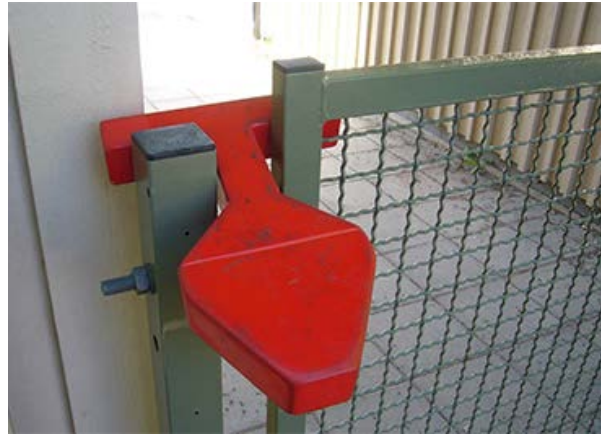
Ställen där barnets hals kan kilas fast vilket medför en stryprisk. Öppningen är farlig eftersom barnet kan få in halsen, men sedan fastna med huvudet. Är det en större öppning kan barnet komma igenom med hela huvudet, alternativt är det en mindre öppning kan halsen inte få plats. Bilderna visar en grind och en klätterställning, men liknande öppningar finns på många staket.
