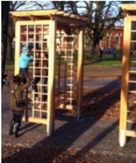
Pergola med stenar, utskjutande delar samt ställen där huvud kan fastna. En familj klättrar i pergolan som är placerad mitt på lekplatsen.
