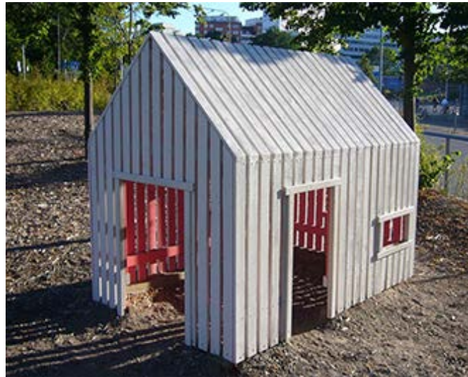
Glipor i taknock på lekhus där snodd på barnkläder kan fastna. När barn tar sig ned från taket kan de fastna och bli hängande. På huset finns även en mängd öppningar där fingrar kan fastna.
