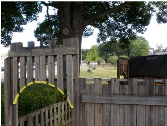
Ställen där barnets hals kan kilas fast vilket medför en stryprisk. Öppningen är farlig eftersom barnet kan få in halsen, men sedan fastna med huvudet. Är det en större öppning kan barnet komma igenom med hela huvudet, alternativt är det en mindre öppning kan halsen inte få plats. Bilderna visar en grind och en klätterställning, men liknande öppningar finns på många staket.
