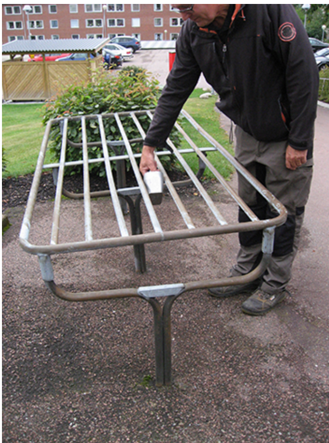
Mattställning i anslutning till lekplatsen som kan uppfattas som en del av lekplatsen. Barn kan komma igenom med kroppen och bli hängande i huvudet i ställningen.
