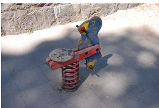
Betongplattor helt utan stötdämpning under fjäderlek
